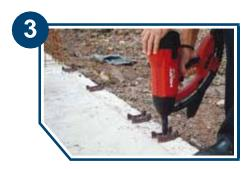
4. Utilizando la herramienta de fijación será más rápida la instalación de los alineadores, además de que las losas no sufren de las fracturas que en la mayoría de los casos se provocan al golpear con un marro.
