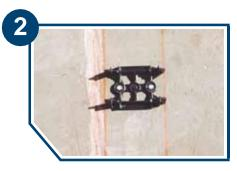
3. Al colocar los clavos se debe de cuidar que el alineador quede en la posición exacta sin salirse del trazado de tal manera que ayude a agilizar el armado de la cimbra.
